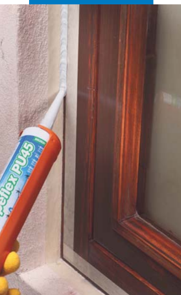
Sellado elástico de juntas
