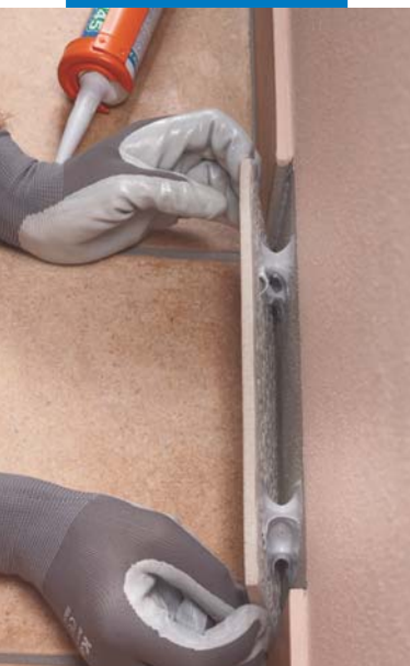
Encolado elástico de elementos de construcción
