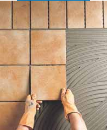
Colocación de klinker en el exterior
