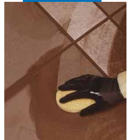
Limpieza y acabado de las juntas con esponja
