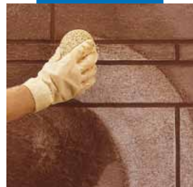
Limpieza y acabado de las juntas con esponja
