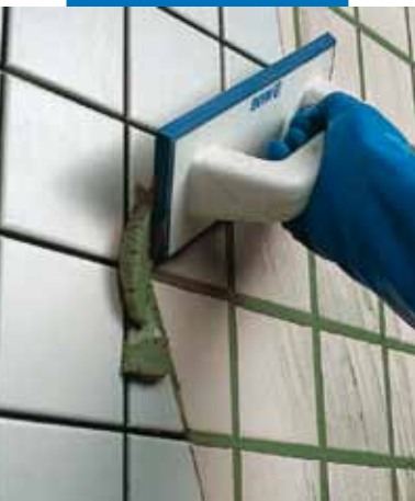
Aplicación de Ultracolor Plus en pared con llana de goma
