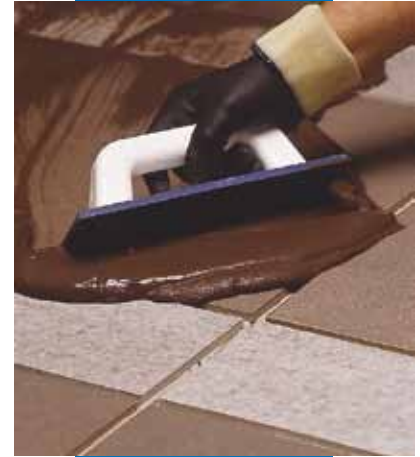
Aplicación de Ultracolor Plus en pavimento con llana de goma
